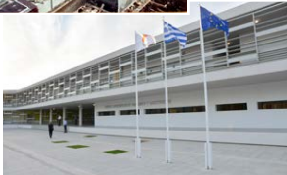
Το νέο κτήριο
